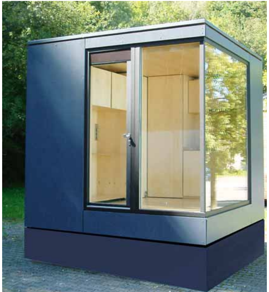
Typ III der Installation raum.27 nach dem Schale-Fleisch-Prinzip, innen hell, außen dunkel.
